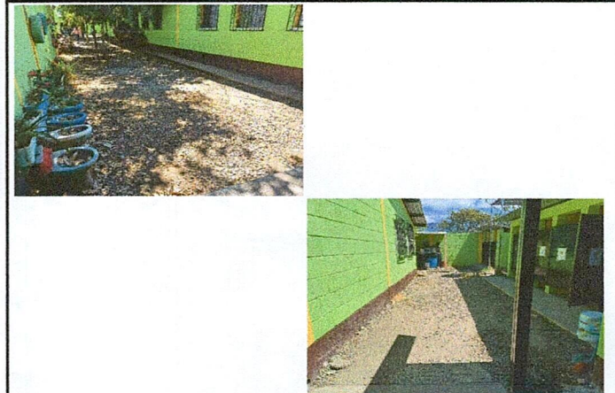
Foto 4: Mejoramiento de losa de patio.
